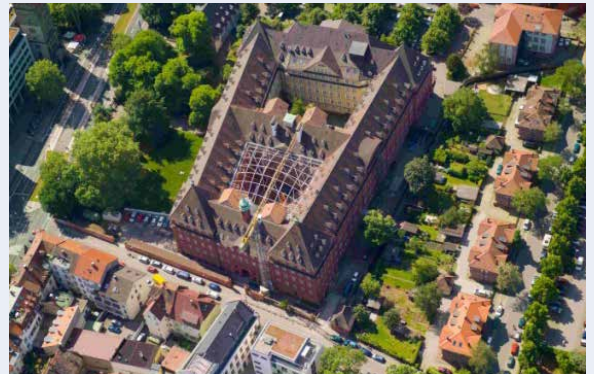
Foto: Vermögen und Bau
